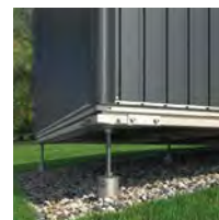
Nastavení výšky pomocí zemních šroubů
